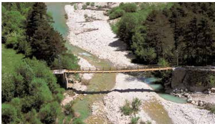
La passerelle suspendue sur l'Estéron construite en 2003 par le Département.
