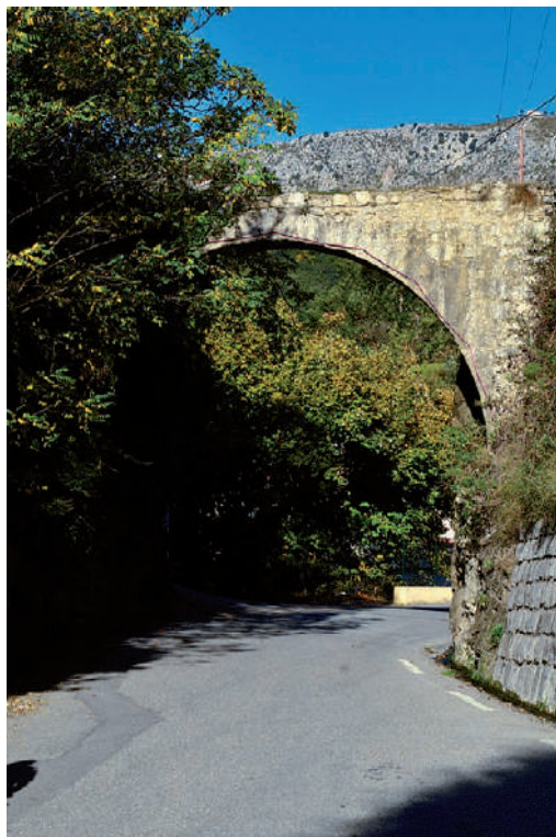
Aqueduc du canal alimentant le village
