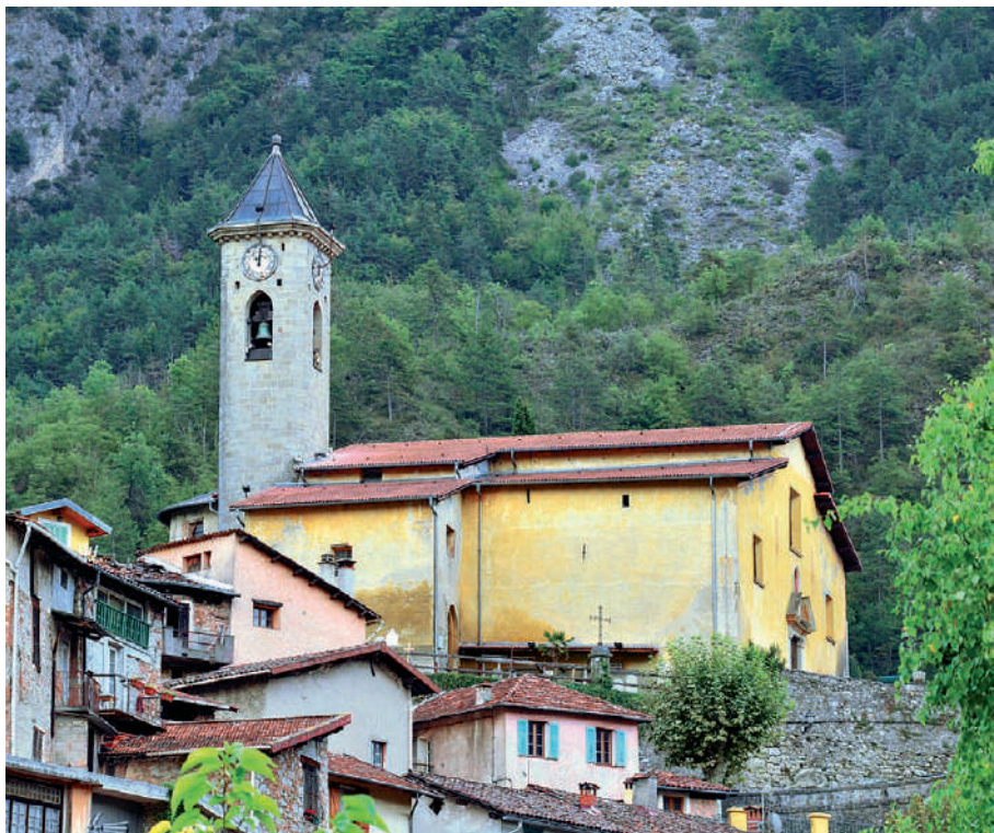
Église paroissiale Saint-Pons
