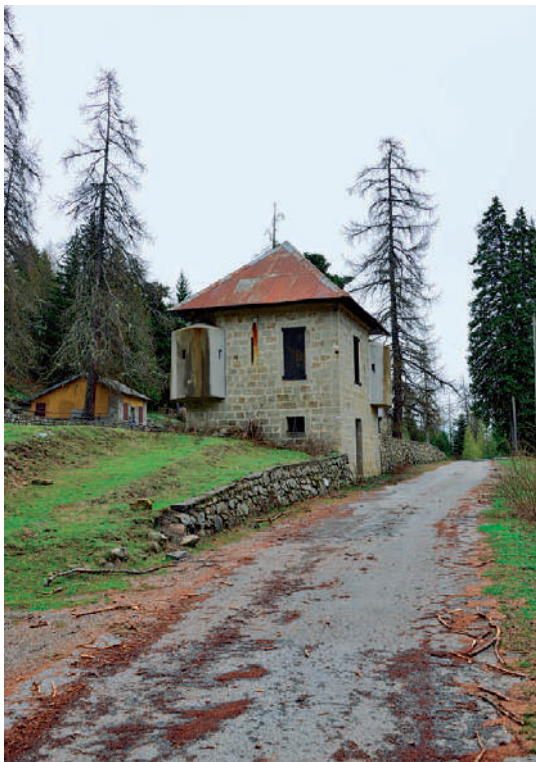
Ouvrage défensif du camp
