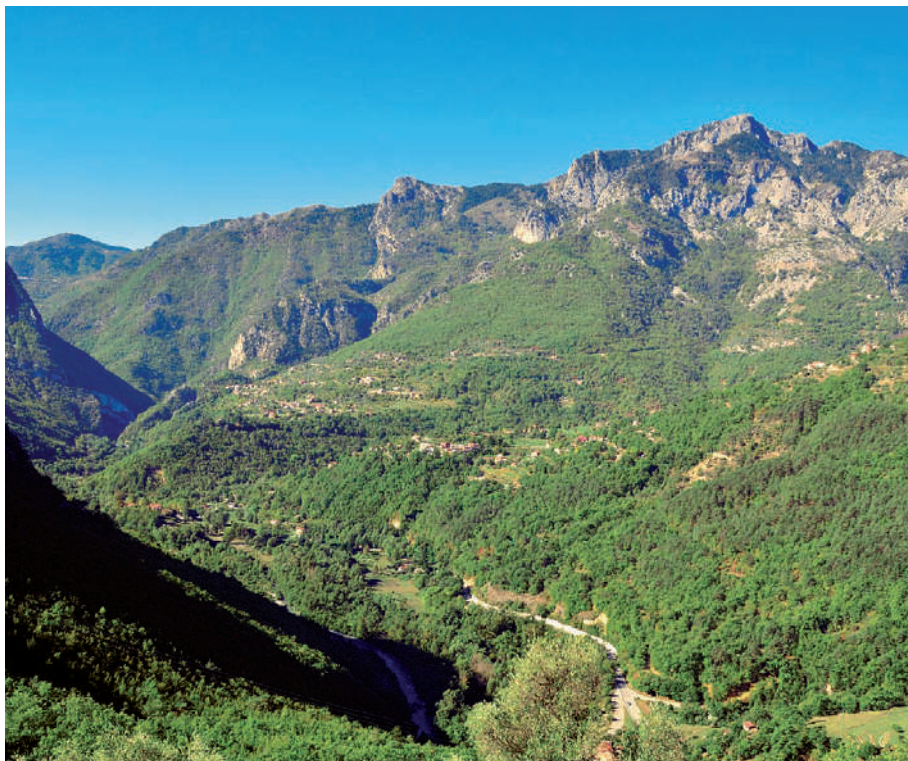
Vue générale des hameaux au sud-ouest de Lantosque
